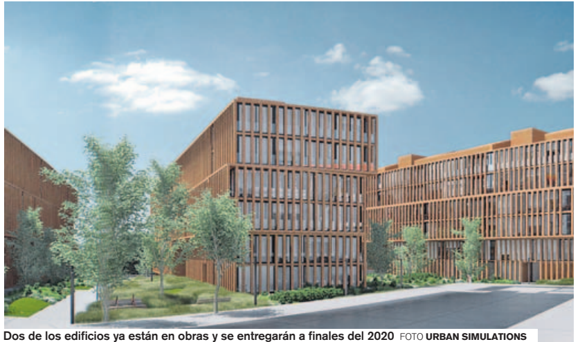
Dos de los edificios ya están en obras y se entregarán a finales del 2020 FOTO URBAN SIMULATIONS
